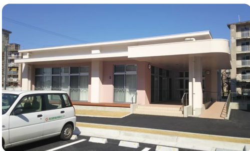
県営住宅(シルバーハウジング)の集会室外観
